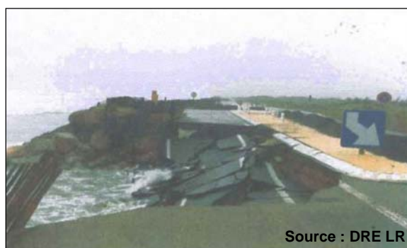
Illustration 28 : Destruction totale de la Digue de Cerbère après la tempête de décembre 2008 (à gauche) et destruction de la RN 112 de Sète à Marseillan après la tempête de décembre 1997
