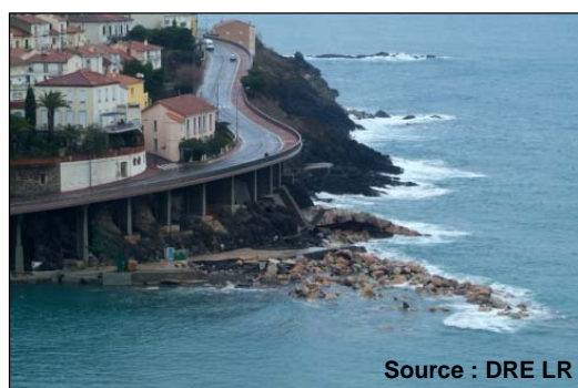
Illustration 28 : Destruction totale de la Digue de Cerbère après la tempête de décembre 2008 (à gauche) et destruction de la RN 112 de Sète à Marseillan après la tempête de décembre 1997
