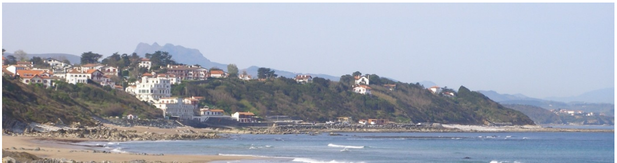
Figure 3 : Commune de Guéthary : la ville s'est développée au sommet des falaises instables et jusqu'au front de mer où sévissent régulièrement les tempêtes
