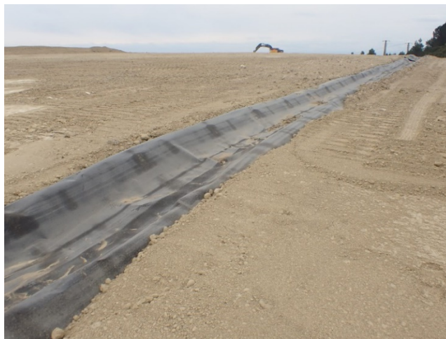
Figure 7. Fossé de surface étanché avec une géomembrane bitumineuse
