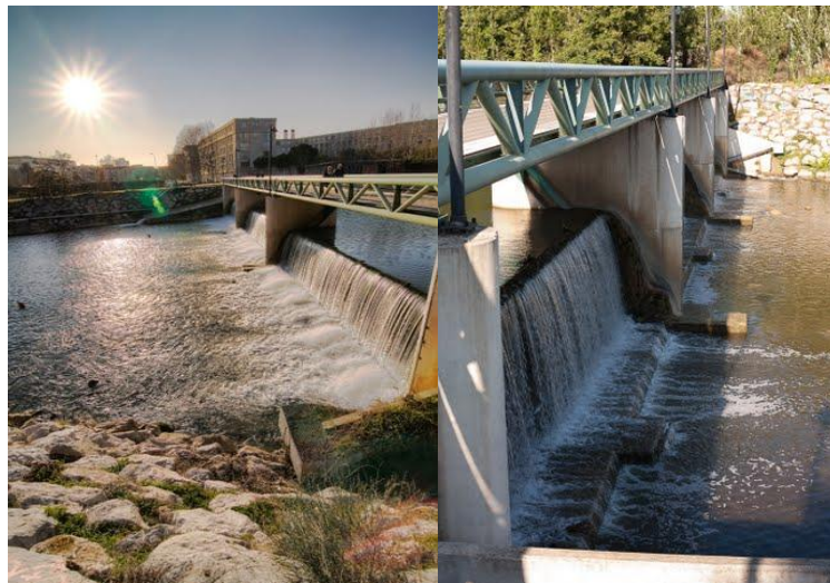
Illustration 95 : Photos du pont de l'Évêque
