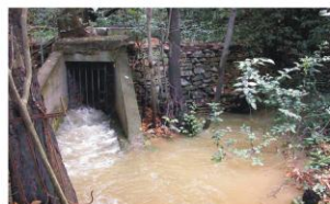
Ancien puits romain et aven karstique mis en charge et inondés par les eaux souterraines © G. Jouanen
