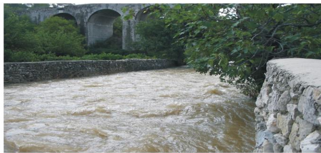
Caderau de Nîmes lors de la crue de septembre 2005 © BRGM
