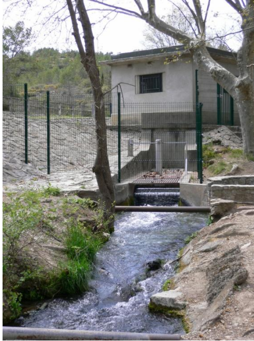
Photo 3 : Déversoir du débit restitué au Lez.
