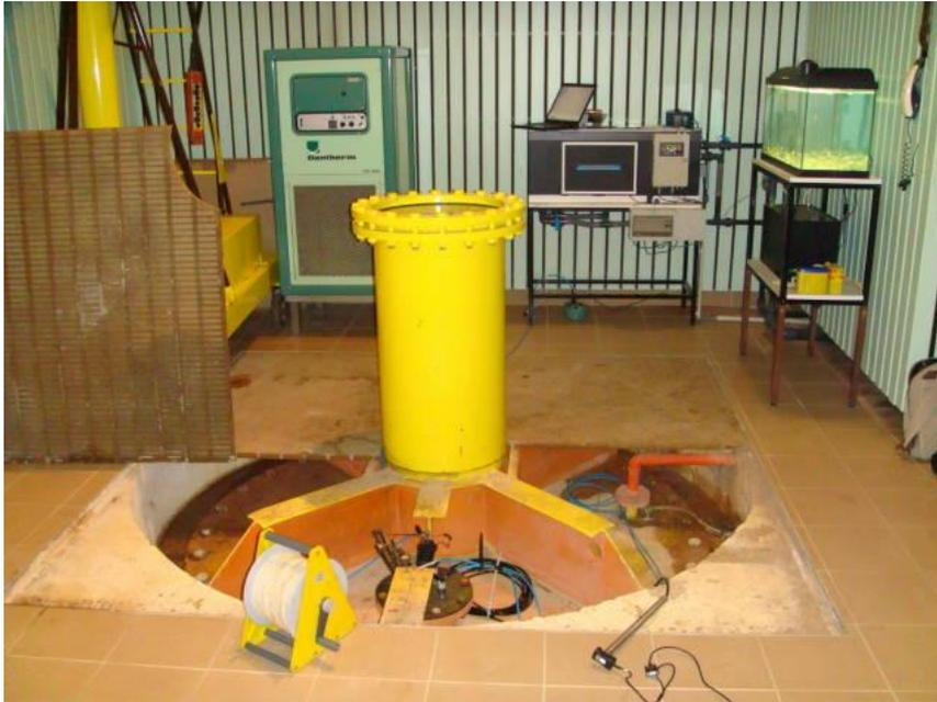
*Photo 1 : Forage n°4 de la chambre de captage de la source du Lez*
