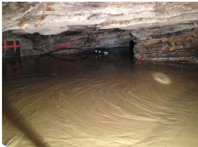
Figure 9 : Mise en œuvre du comblement
