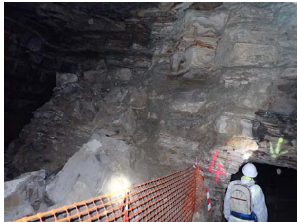
Figure 11 : Pilier partiellement effondré
