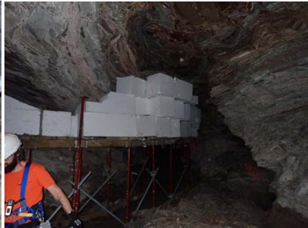
Figure 6. Chutes de toit
