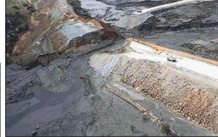
Ruptures de digues de retenue à Aznalcóllar (25 avril 1998 en Espagne)
