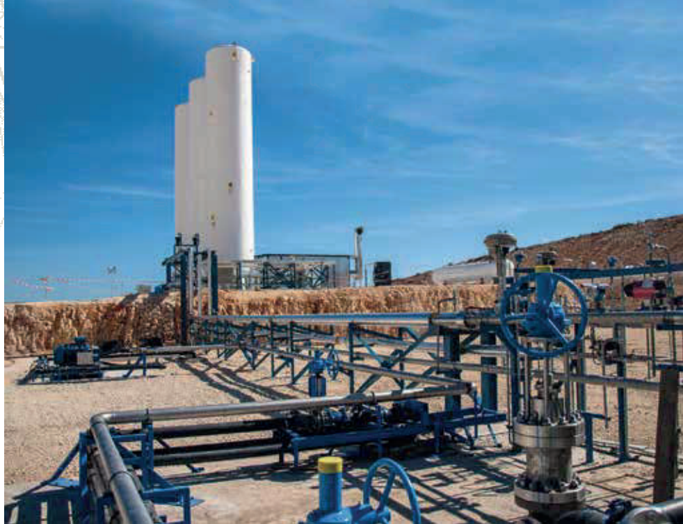
▲ Fig. 12 : Site pilote de stockage géologique de CO 2 d'Hontomin : au premier plan, la tête de puits et les installations d'injection du CO 2 , avec les différents tuyaux qui amènent le CO 2 contenu et conditionné dans les installations situées à l'arrière-plan.
