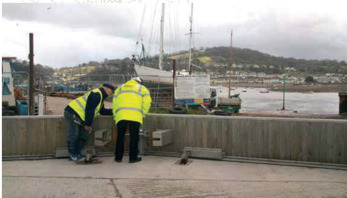
◀ Fig. 7 : Mise en place d'une porte étanche contre les submersions marines à Teignmouth, en Grande-Bretagne.
