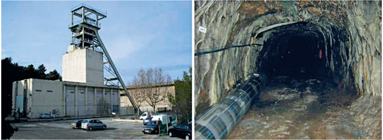
Figure 2 - À gauche, le puits Gérard ; à droite la Galerie de la Mer avec le tuyau transportant l'eau pompée.
