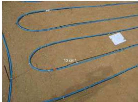
Fig. 1 – Disposition horizontale du tuyau et de la fibre optique
