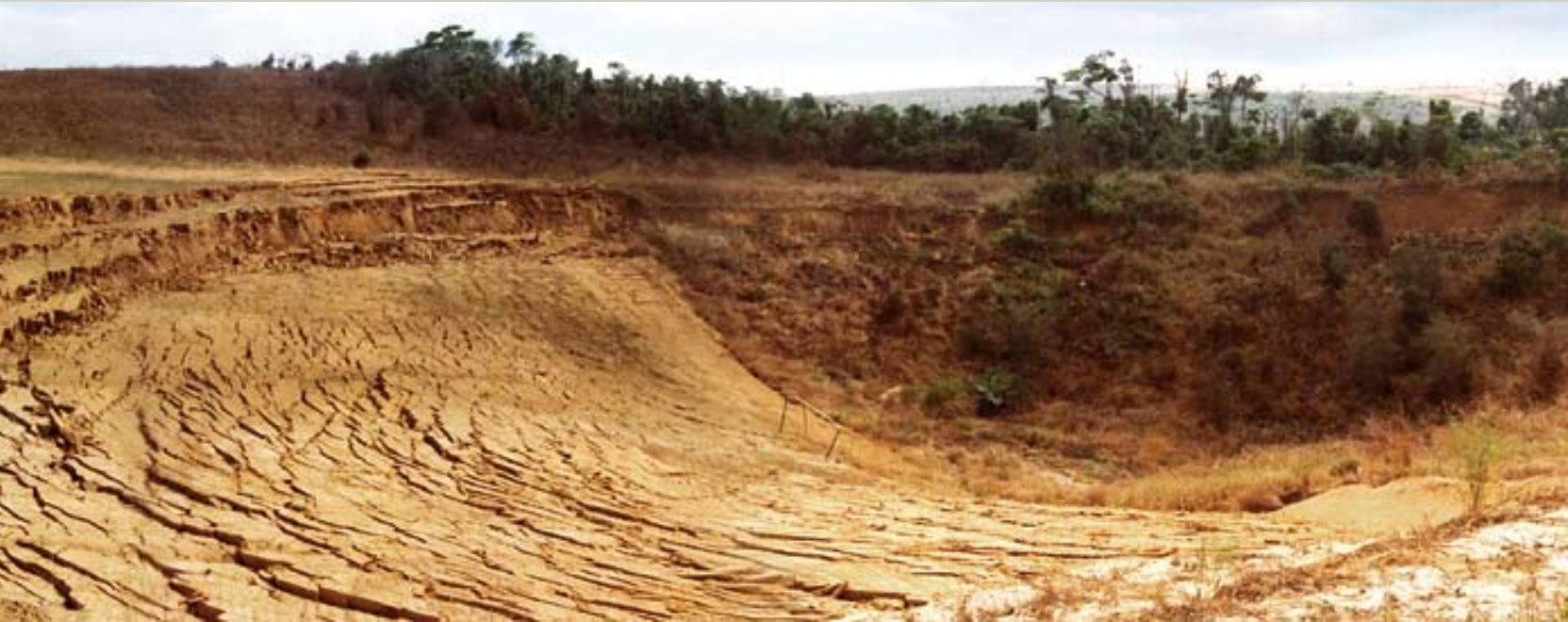
▲ Photo 2 : Inondation de la mine de potasse de Holle (Congo) – effondrement n° 1.
