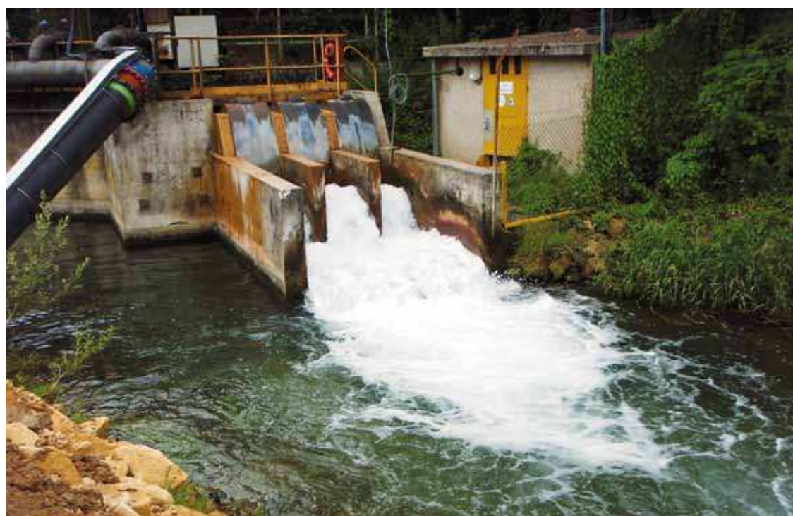
◀ Photo 2 : Débordement du bassin nord à la galerie de la Paix (bassin ferrifère lorrain) ; le débit annuel moyen est de l'ordre de 1 m 3 /s. Photo 2: Overflow from the northern basin at the Gallery de la Paix (Lorraine iron-bearing basin); the annual flow rate is approximately 1 m 3 /s. © R. Fabriol.
