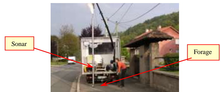
Figure 7 : Inspection par sonar d'une cavité
