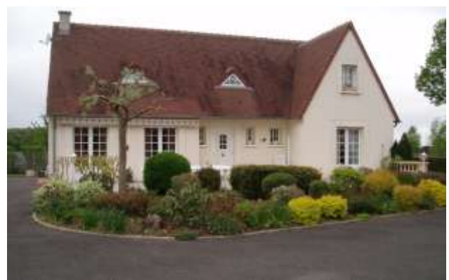
Figure 6 : Vue du pavillon à mettre en sécurité
