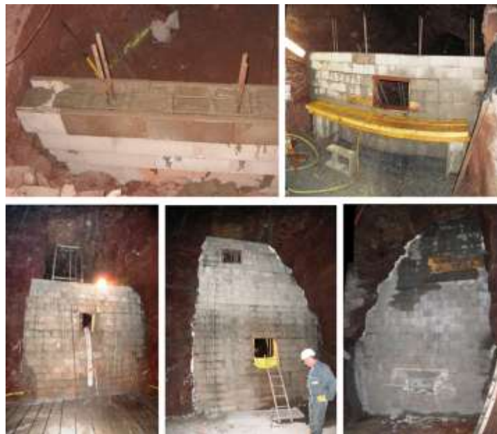
Figure 9 : Montage des murs de confinement
