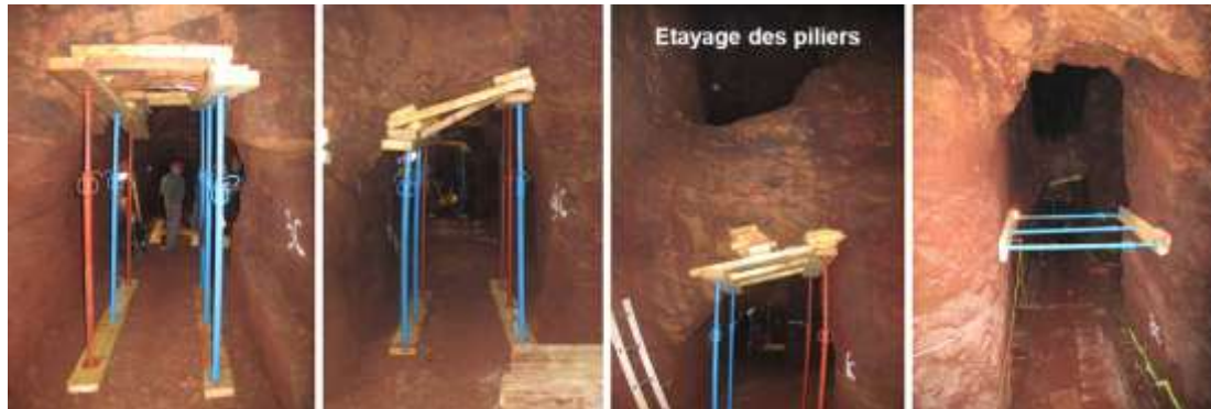
Figure 8 : Etagage des piliers
