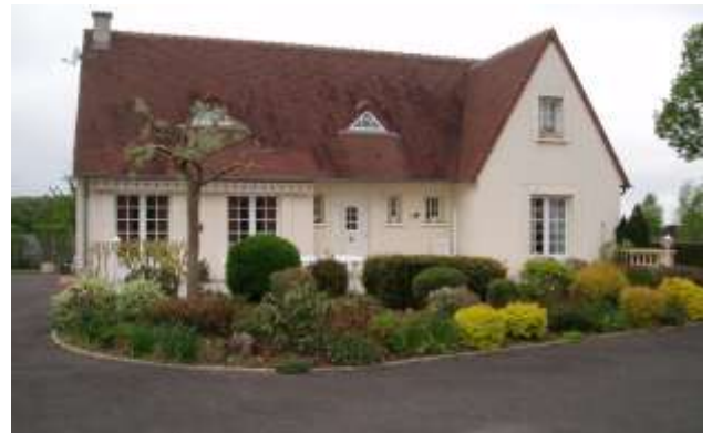
Figure 6 : Vue du pavillon à mettre en sécurité
