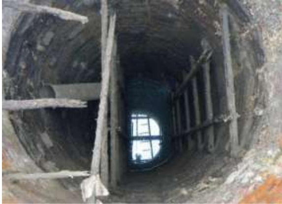
Figure 10 - Intérieur du puits après ouverture
