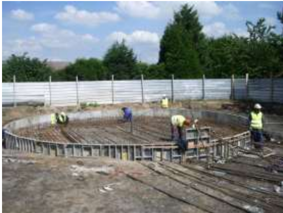
Figure 12 – Mise en œuvre coffrage ferrailage
