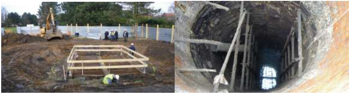
Figure 3 : travaux de mise en sécurité du puits n°1 d'Annezin (Pas de Calais)
