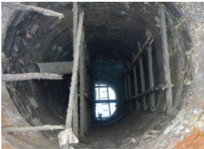
Figure 10 . Intérieur du puits après ouverture
