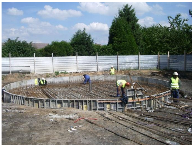
Figure 12 . Mise en œuvre du coffrage ferrailage
