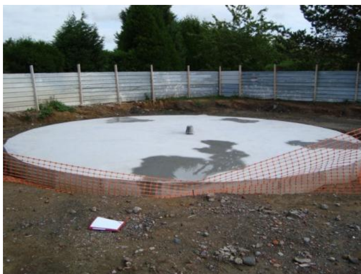
Figure 13 . Dalle de fermeture du puits
