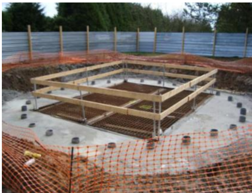
Figure 11 . Plan de travail du jet-grouting
