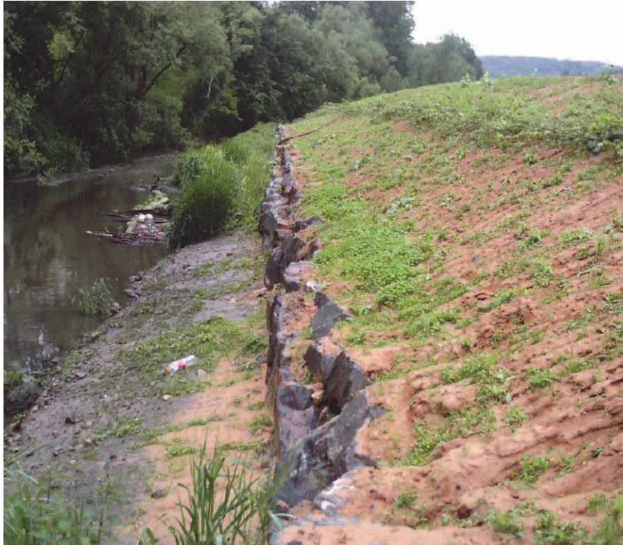
Figure 4. Photo du flanc Ouest – enrochement, couche de végétation et plantations
