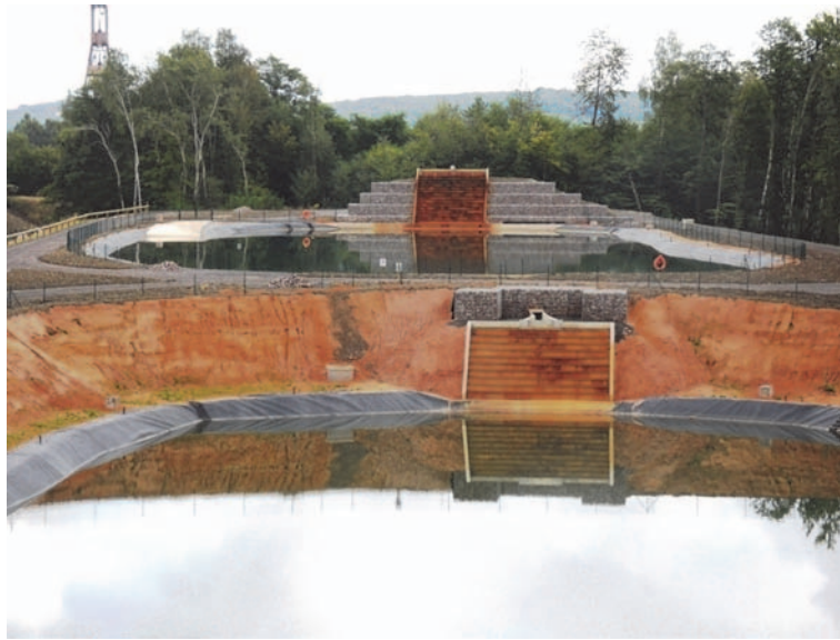
Figure 8. Ouvrages bassins 1 et 2 en phase d'essais hydrauliques
