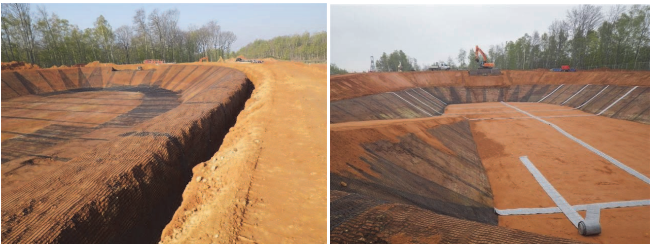
Figure 7. Pose de la géogrille avec ancrage, mise en place des 0.20 m de limon et des bandes de dégazage
