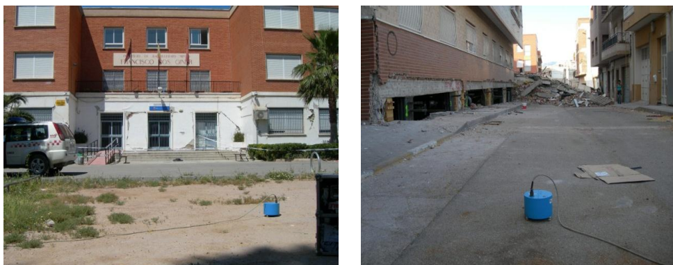
Fig. 4. Fotografías de dos emplazamientos de medida de ruido sísmico: punto LOR2 instituto Francisco Ros Giner (izquierda) y punto LOR7 edificio colapsado durante el sismo (derecha).
