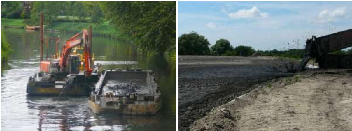
Figure 5: Curage non sélectif et mise en dépôt, Canal de Lens, 2010
