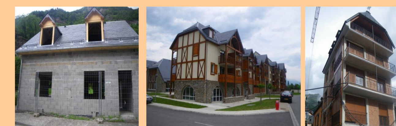
Habitat individuel en maçonnerie agglomérée. Habitat collectif en voiles béton. Habitat collectif en poteaux-poutres
