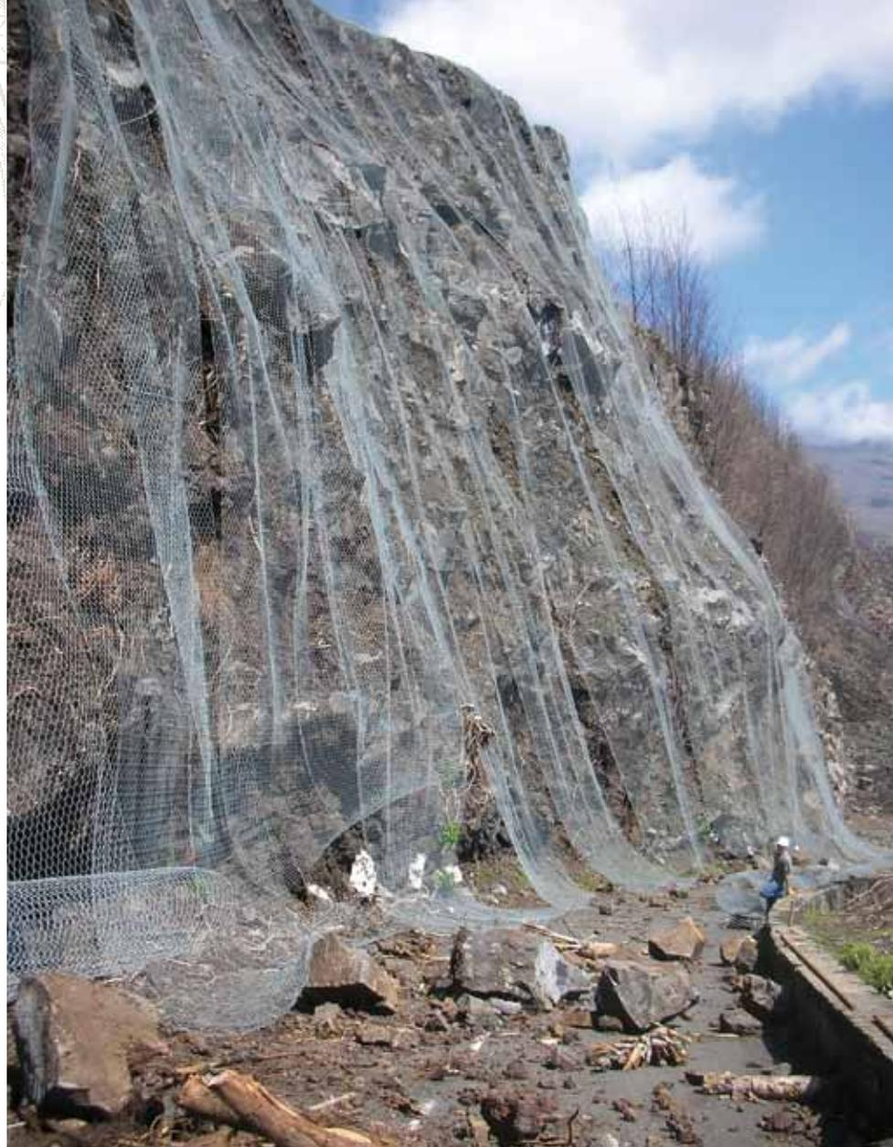
côté mer. La pose de filets de protection en falaise a permis de limiter le risque de chutes de pierres et ainsi d'optimiser l'exploitation de cet axe stratégique, essentiel à l'économie de l'île (photo 3). Aucun accident grave lié à des chutes de blocs n'a été à déplorer depuis 2008.
