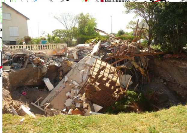
Effondrement d'origine karstique à St-Pryvé-St-Mesmin (45) 22 mai 2010
