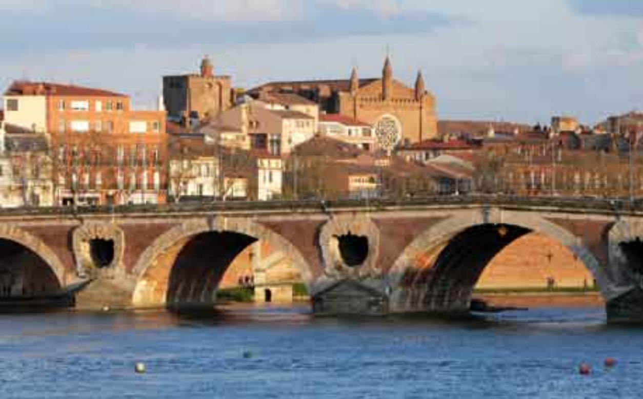
▲ Toulouse. Le Pont Neuf franchit la Garonne et repose sur les alluvions du lit mineur du fleuve. In Toulouse, the Pont Neuf spans the Garonne River and rests on the alluvia of the river's streamway. © Fotolia
