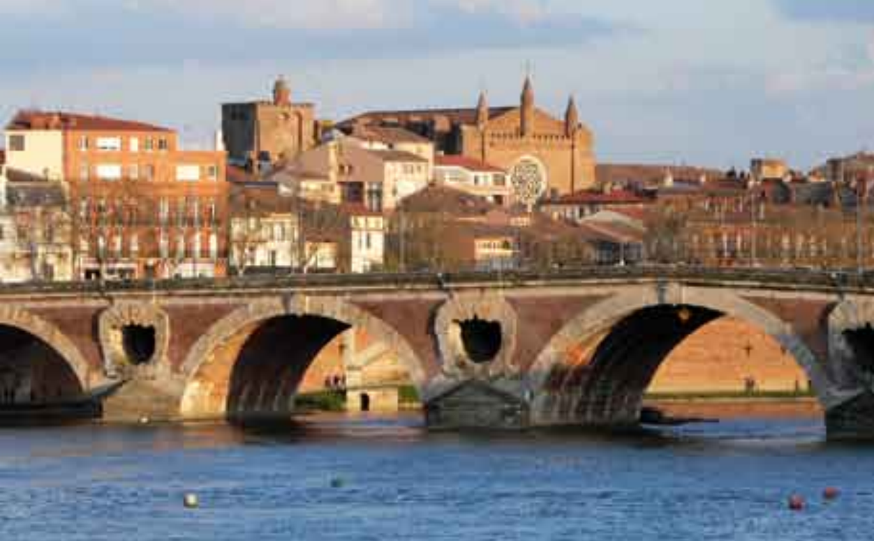
▲ Toulouse. Le Pont Neuf franchit la Garonne et repose sur les alluvions du lit mineur du fleuve.
