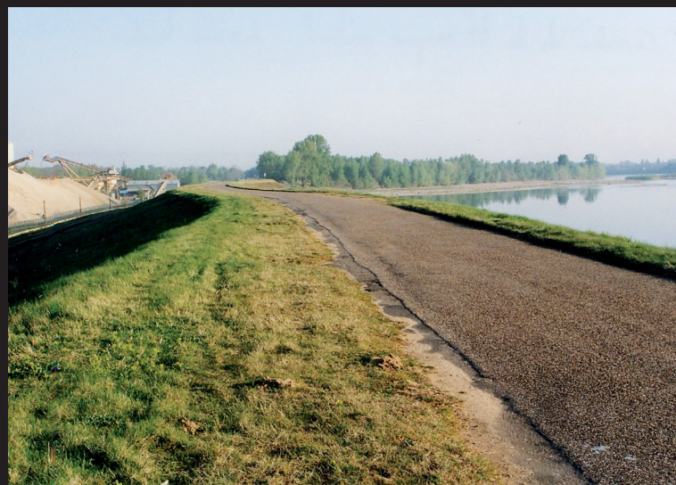
Photo 2 : Levée moderne de la Loire moyenne en Val d'Orléans (Sandillon) Photo 2: Modern levee in Middle Loire Valley, Val d'Orléans (Sandillon)
